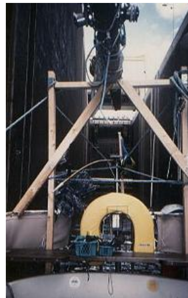
Så här såg träkonstruktionen ut som bar upp Balladmasten.
