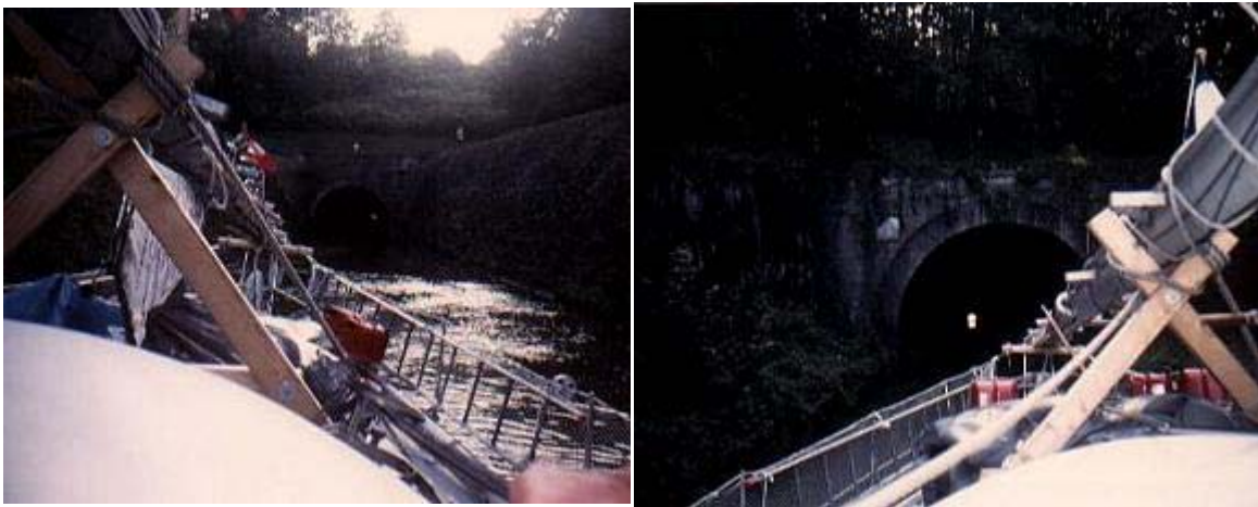
En av kanaltunnlarna
