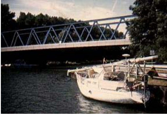
I väntan på broreparation.
